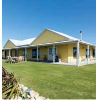
865 MALINONG ROAD, MALINONG
